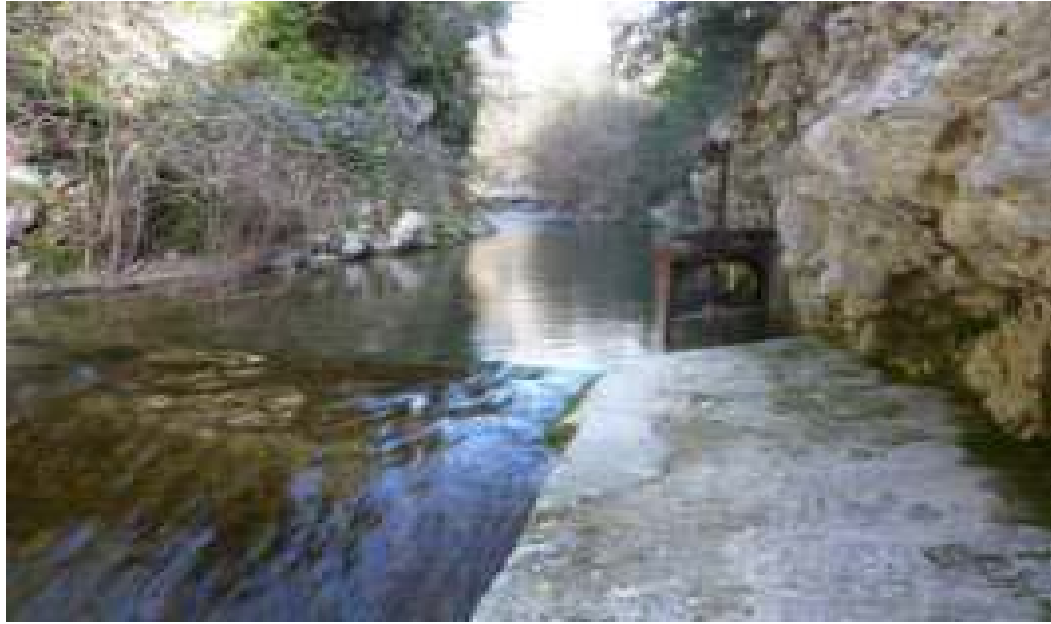
Vue globale du seuil + chaussée avec eau Usine Electrique
