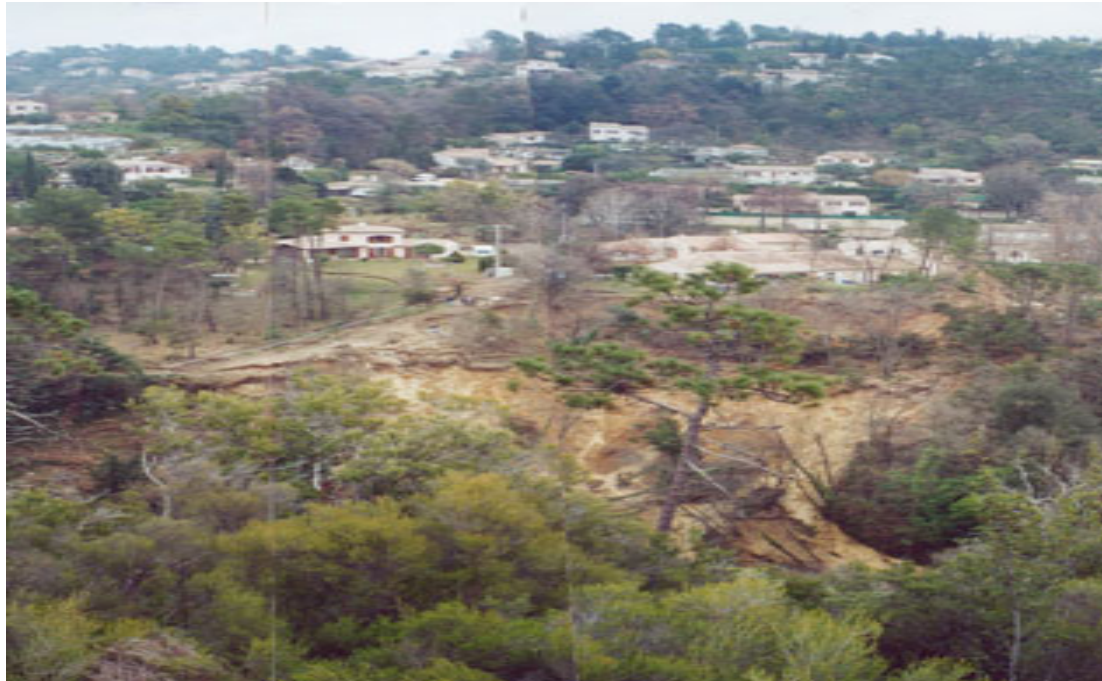
Glissement de terrain du Pra Julian
